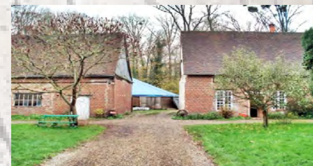
4 LA GRAINERIE Surface : 300 m 2 sur 2 niveaux
